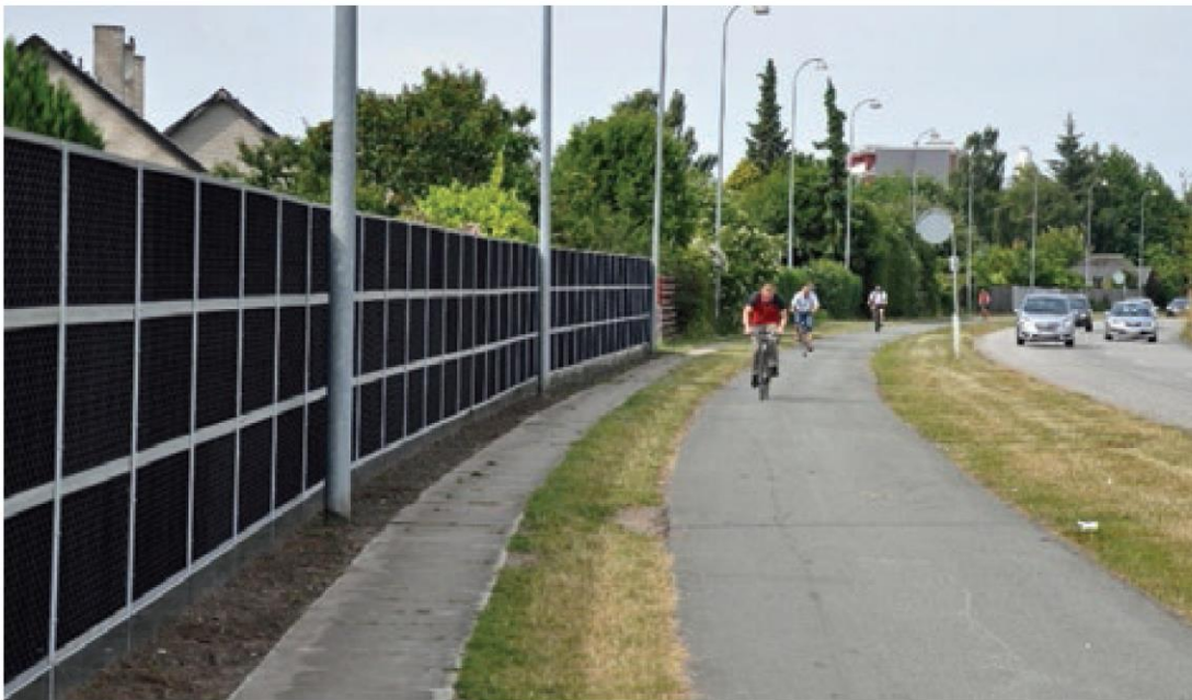
Εικόνα 8: Ηχοπετάσματα από ανακυκλωμένα σύνθετα υλικά, Κοπεγχάγη Δανία. Πηγή: Miljoskarm.dk 84
