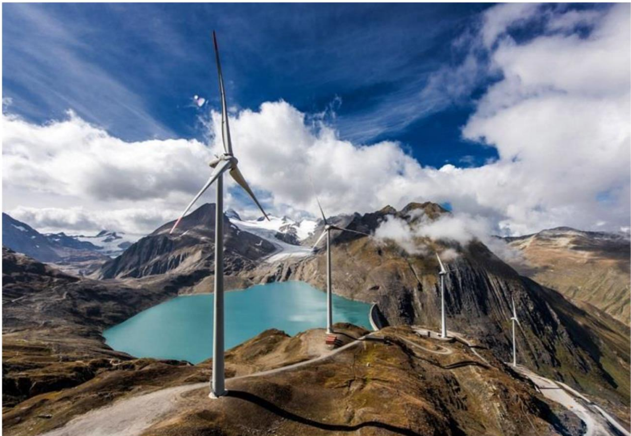
Το πιο ορεινό αιολικό πάρκο της Ευρώπης, που βρίσκεται σε υψόμετρο 2.500m στην λίμνη Griessee, Ελβετία. Πηγή: https://www.swisswinds.com
