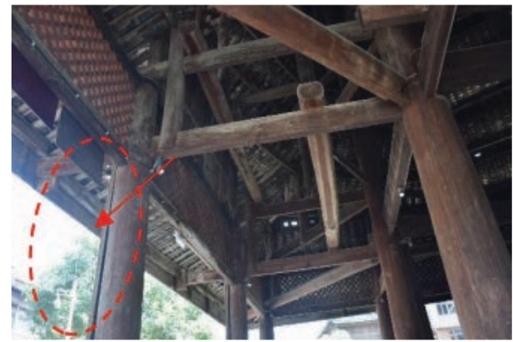
(d) Cracking of eaves columns
